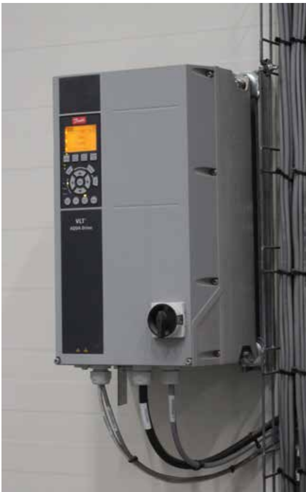
De VLT® AQUA Drive FC 202 regelt pompen en blowers in de grote biogasinstallatie.
